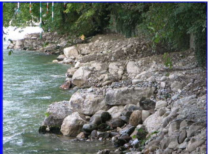
Ufervorschüttung und Buhnen am Badener Ufer
