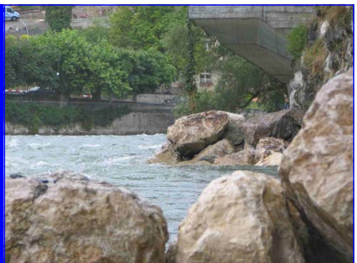
Buhnen aus grossen Kalkblöcken unterhalb der Bädergarage
