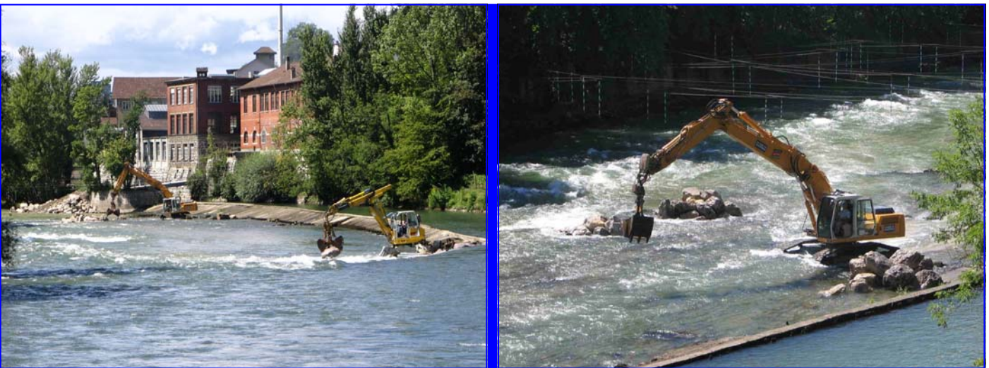
Menzi-Muck und Bagger im nicht ungefährlichen Einsatz am Oederlin-Wehrkopf und in der Slalomstrecke. Bilder: Matthias Röthenmund
